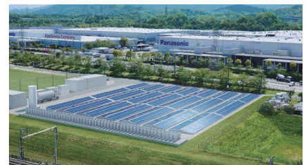
Panasonic 日本草津燃料電池工廠用電，由 PV + 蓄電 + 氫燃料電池的組合供給（2022 年 4 月開始運行）
