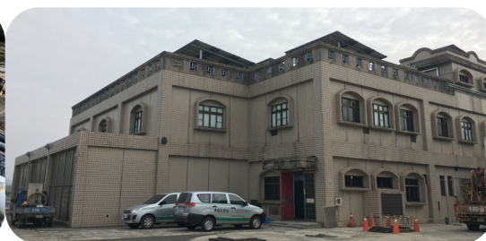
美濃二次變電所
